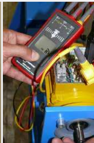
Controllo della rotazione del motore prima del collegamento
