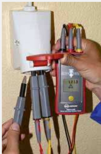
Convalida del cablaggio della presa
