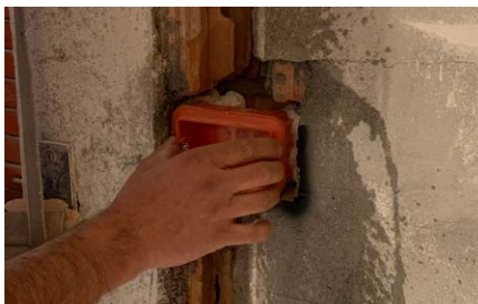
Pre-fissaggio di scatole elettriche.
